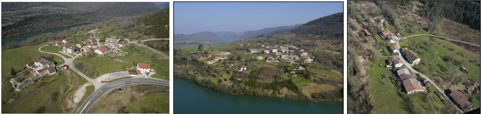
Vues aériennes du village de Serrières, de Merpuis, et de Sonthonnax-le-Vignoble
