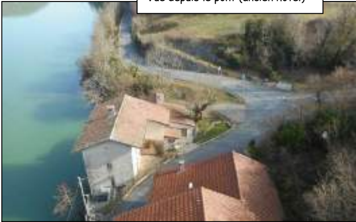
Vue depuis le pont (ancien hôtel)
